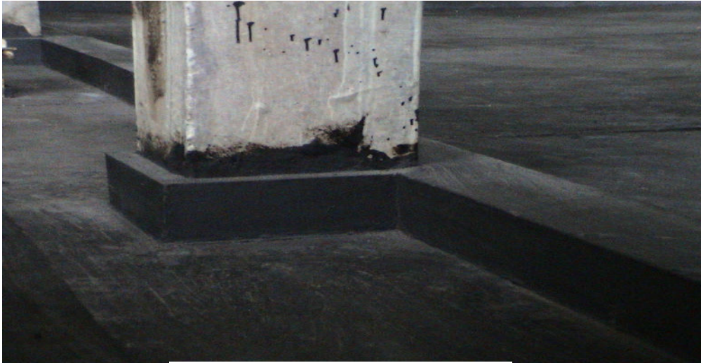
呖喃树脂混凝土地坪、反沿及踢脚线
