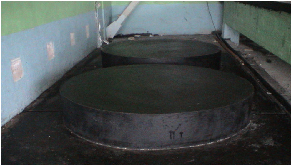
呖喃树脂混凝土地坪及设备基础
