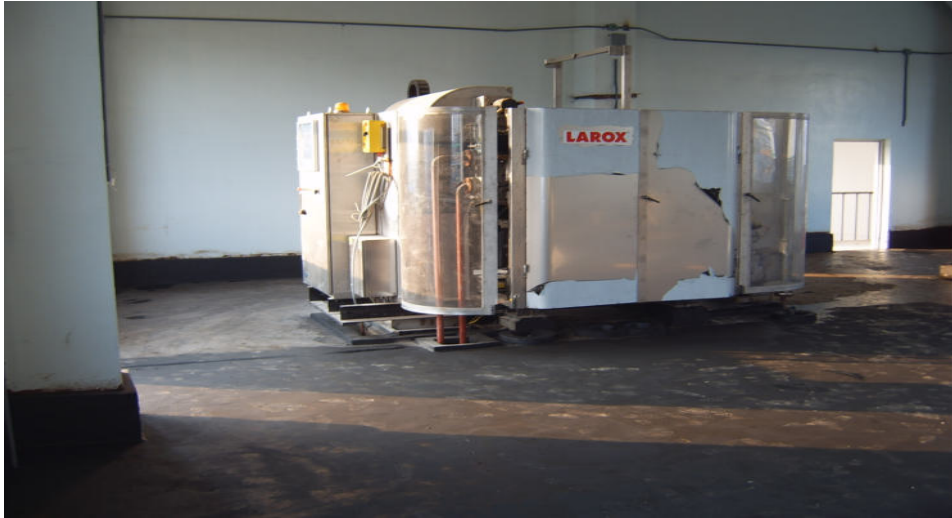
呖喃混凝土楼地面、踢脚线及设备基础
